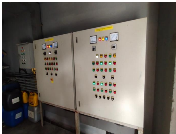
รูปที่ 1-10 ตู้ควบคุมระบบบ่อบำบัดน้ำเสีย
