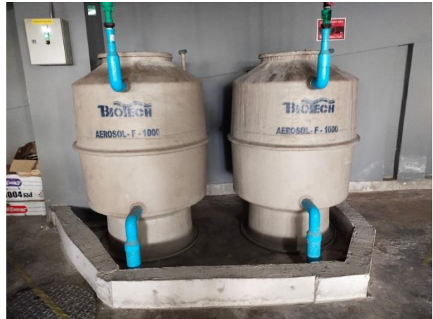
รูปที่ 1-9 ถัง Aerosol
