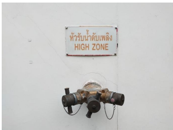
รูปที่ 1-24 หัวรับน้ำดับเพลิงภายนอกอาคารส่วน HIGH ZONE
