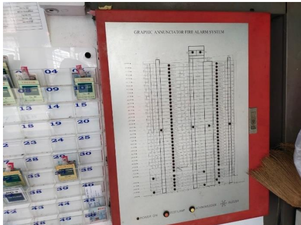
รูปที่ 1-20 แผงควบคุมระบบสัญญาณแจ้งเหตุเพลิงไหม้
