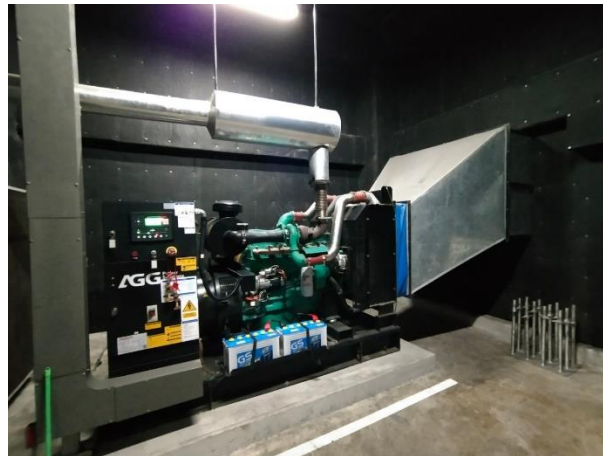
รูปที่ 1-18 เครื่องกำเนิดไฟฟ้าสำรอง
